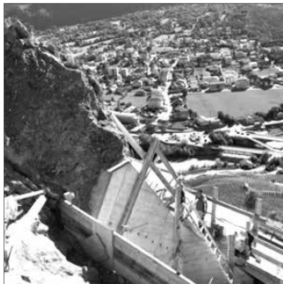
Felssicherung mit Blick Richtung Kinderdorf und Färbi.
