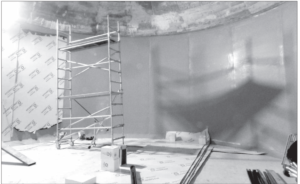
Sanierung Reservoir Tschablen, Leukerbad
