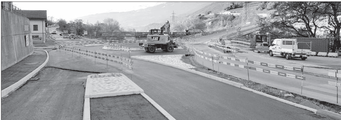
Neuer Kreisel Rottenbrücke vor Bauabschluss
