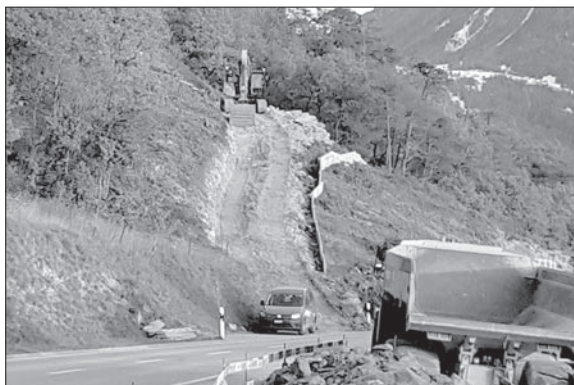
Bauarbeiten neuen Erddamm
