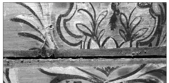
Alte Suste: Deckenmalerei von 1714. Foto ARGE Lochmatter-Wirthner
