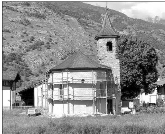
Es geht vorwärts mit der Kapellenrenovation.
