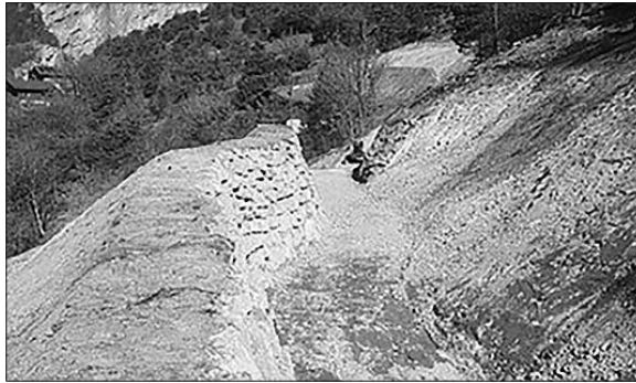
Neuer Erddamm in St. Barbara.
