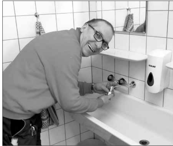
Hauswart Thomas Grichting bei der Montage der Aquaclics.
