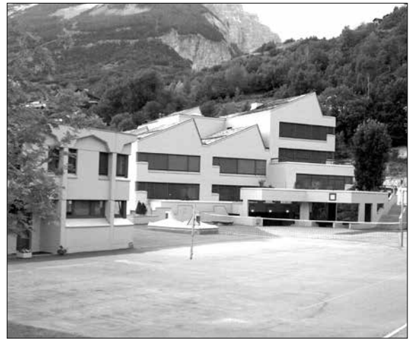
Regionalschulhaus in Leuk-Stadt.
