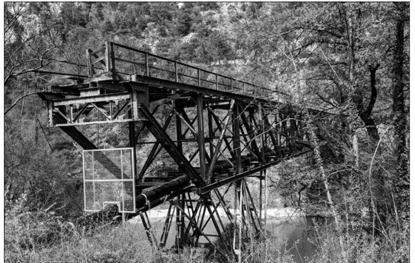
Die alte Rufibrücke beim Bahnhofgelände
