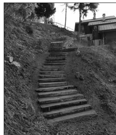
Zivilschutz Albinen Erneuerung einer Treppe mit Eisenbahnschwellen
