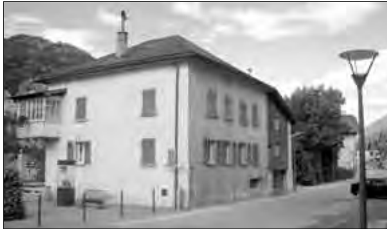
Das Wohnhaus Sewer wird abgerissen
